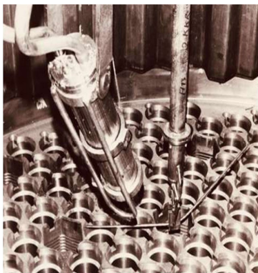
Erproben des fernbedienbaren Greifers mit Kamera
