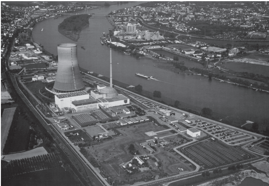
Abb. 6: Blick auf das Kernkraftwerk aus Richtung Koblenz, rechtsrheinisch die Stadt Neuwied, weiter linksrheinisch Weibenthurm (Foto: RWE Power AG)
